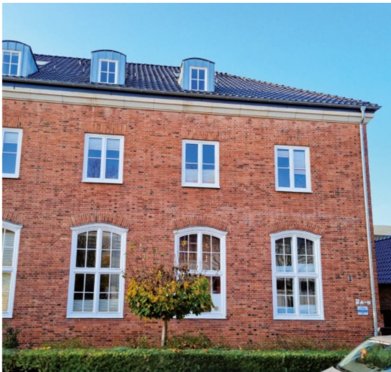
Hausansicht Tagesklinik in der Spillerstraße 2a-b in Lübeck
